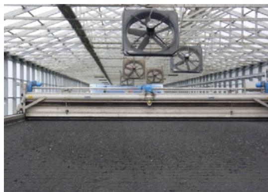
Bild 12.2: Foto einer solaren Klärschlamm-trocknung (ISWW)
