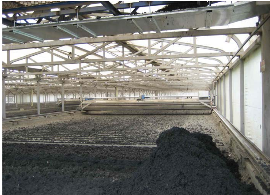
Solare Klärschlamm-trocknung, Kolumbien (Foto: Bauerfeld, ISWW)
