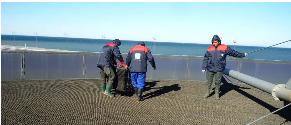
Untersuchungen an einem Tropfkörper, Georgien (Foto: GEA 2H)
