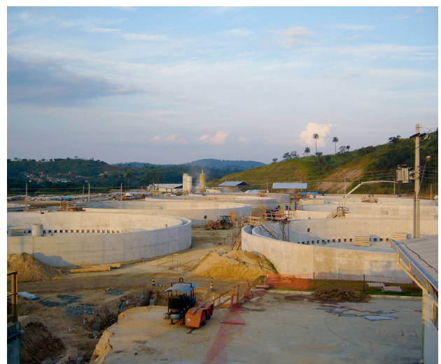
Bau von Tropfkörpern auf einer Kläranlage in Südamerika
