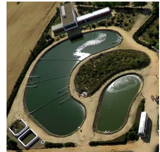
IEEM-Pilotanlage, Sevilla, in Zusammenarbeit mit Fuchs Enprotec GmbH (Foto: CENTA)
