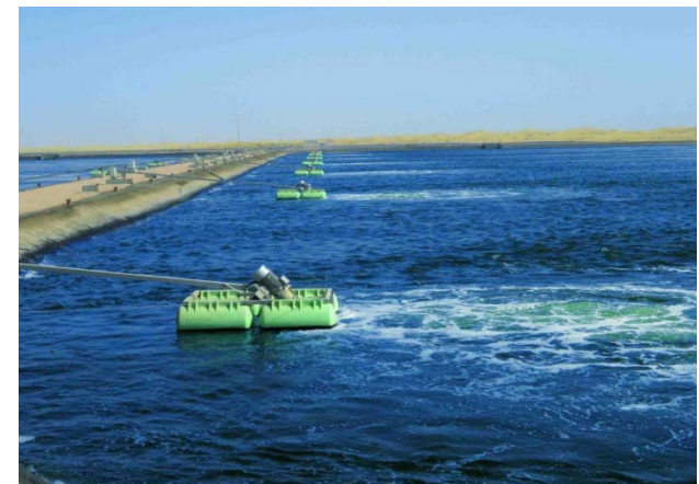
Abwasserteich in Algerien, 275.000 E (Foto: FUCHS)
