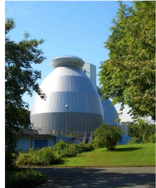
Kläranlage Bottrop (Foto: TU Braunschweig)
