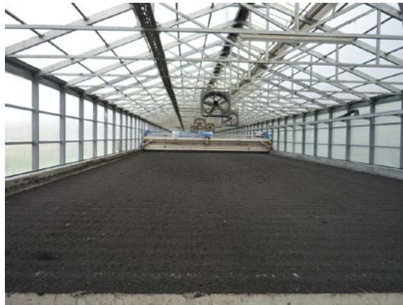
Kläranlage Kłodzko (Foto: TU Braunschweig)
