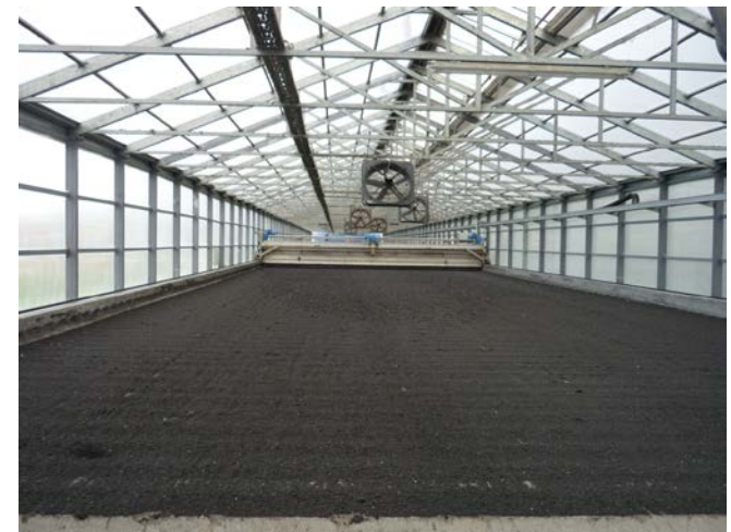
Kläranlage Kłodzko (Foto: TU Braunschweig)
