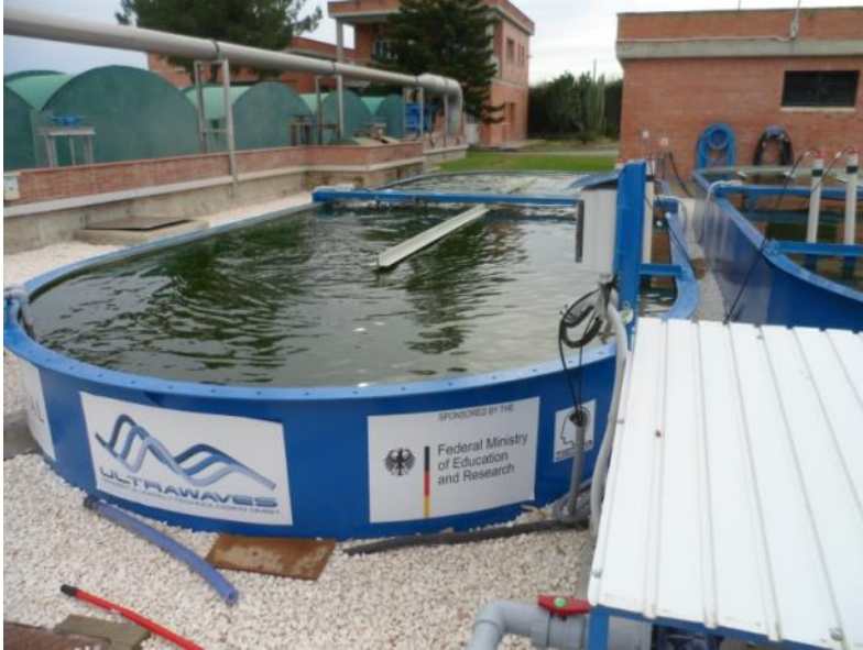
Versuchsanlage symbiotische Algen-Bakterien-Teiche, Chiclana, Spanien
