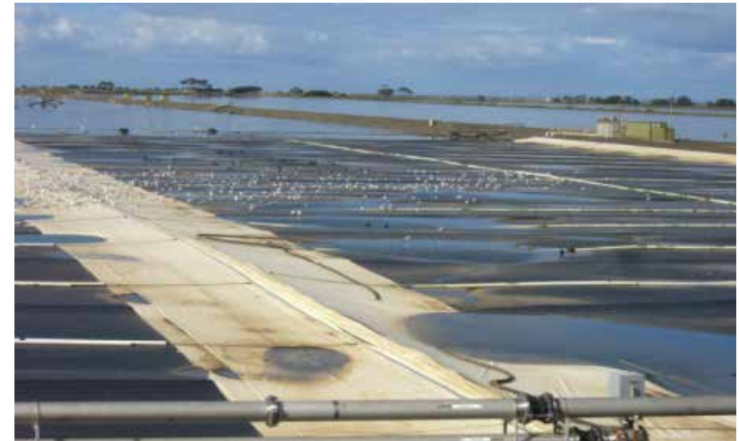
Abgedeckte Teiche zur Gasfassung in Warraby/Melbourne, Australien
