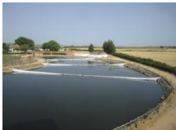
Belüftete und unbelüftete Abwasserteiche Sevilla
