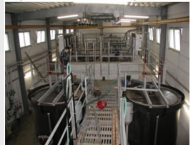
Ergänzend: Pilotanlage Düsseldorf
