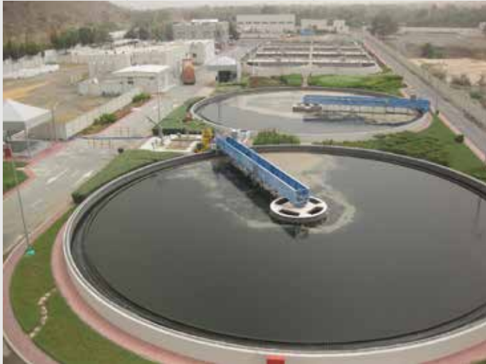
WWTP Syana FZC (Fujairah, VAE)
